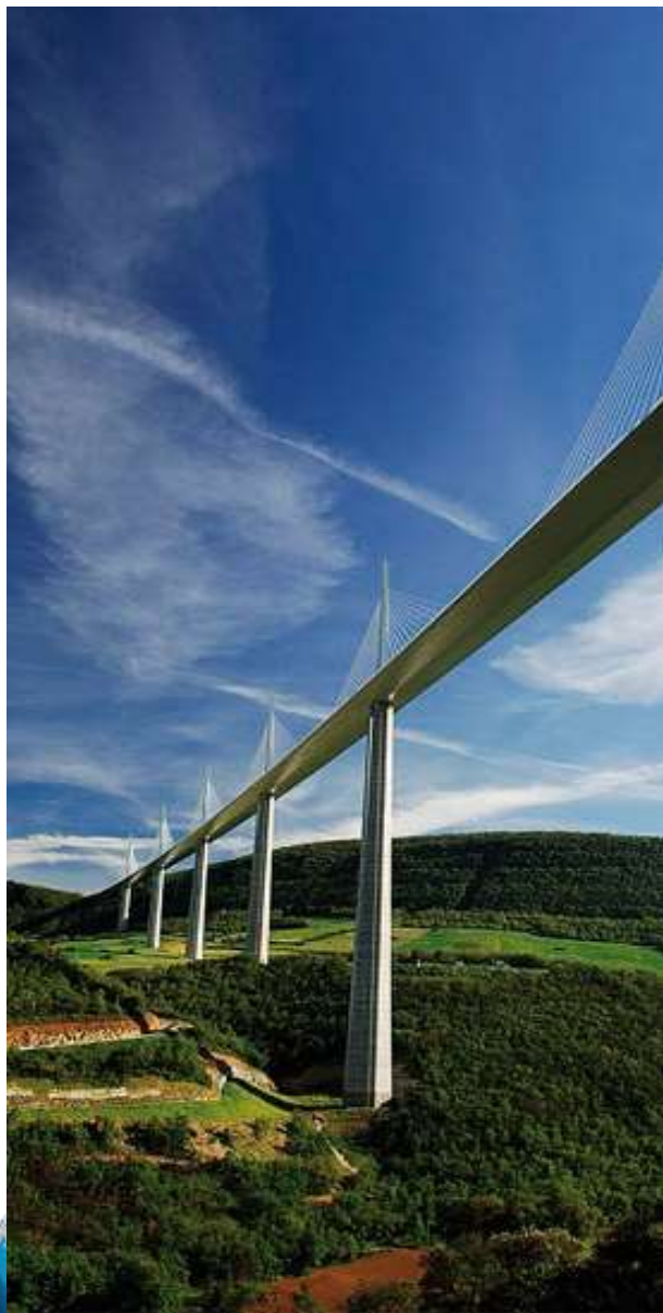
le Viaduc de Millau
